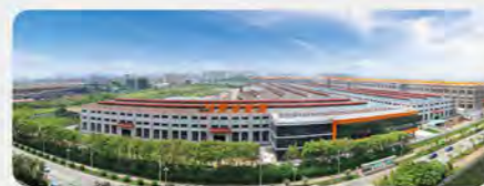
震雄深圳工业园——生产总部
