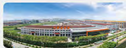
震雄深圳工业园——生产总部
