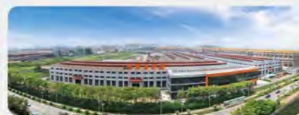
震雄深圳工业园——生产总部
