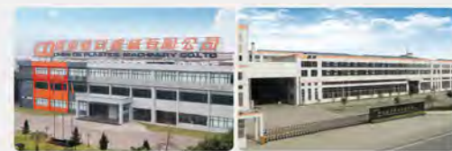
震雄顺德生产基地
